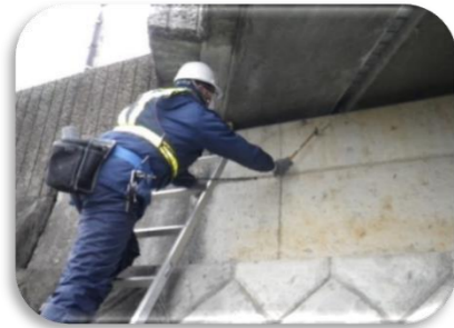
近接調査風景
