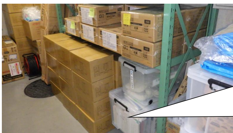
防災倉庫①
