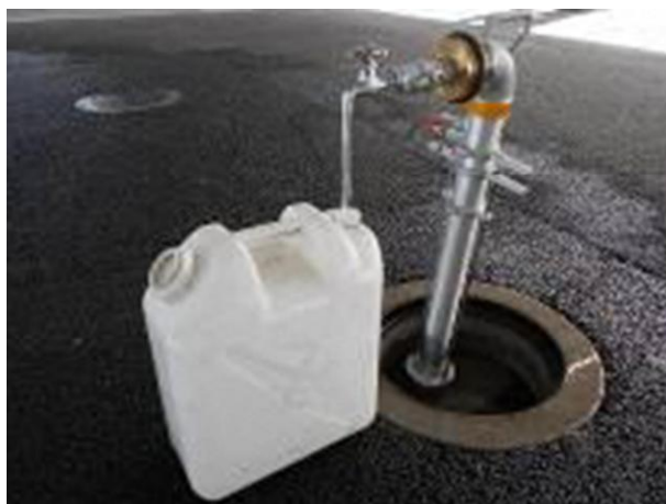
応急給水栓による給水状況
