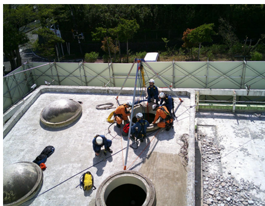
受水槽内の救助活動訓練
