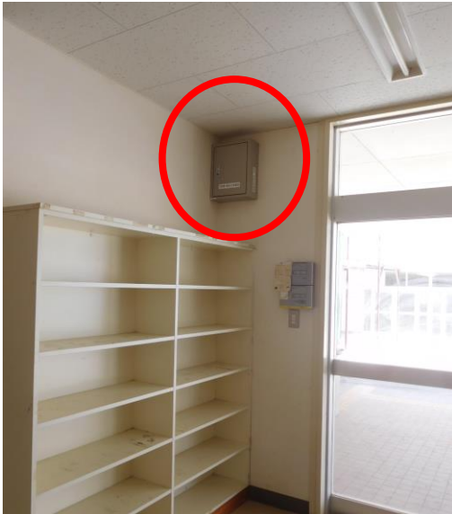
体育館出入口付近
