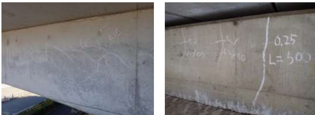
写真 1 ひびわれによるC 1 判定（左：26_長者橋、右：31_西の橋）
