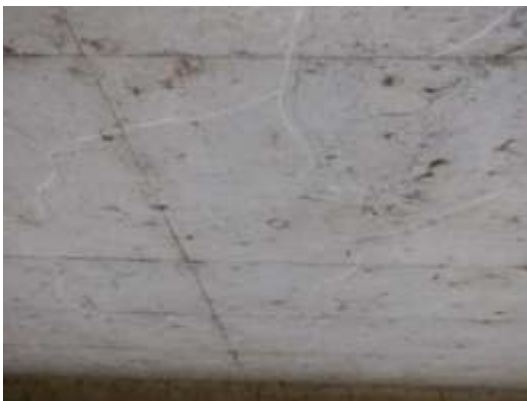
写真 4 ひびわれ、剥離・鉄筋露出による C 1 判定 (左 ; 50_河原方公園西橋、右 ; 47_無名橋 46)
