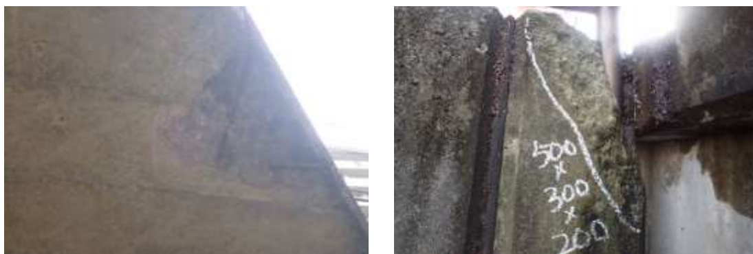
写真 2 剥離・鉄筋露出によるC 1 判定（左：1_稲城中央橋、右：14_馬橋）
