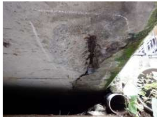
写真 4 ひびわれ、剥離・鉄筋露出による C 1 判定 (左 ; 50_河原方公園西橋、右 ; 47_無名橋 46)
