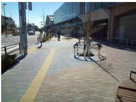
エコセメント製品の使用事例（矢野口駅前の舗装）
