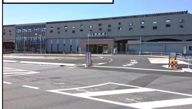
写真B 現況駅前広場
