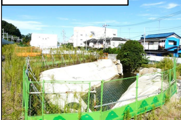
写真A 大丸用水切替え工事
