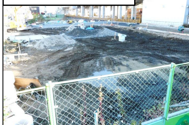
写真B 駅前広場整備工事
