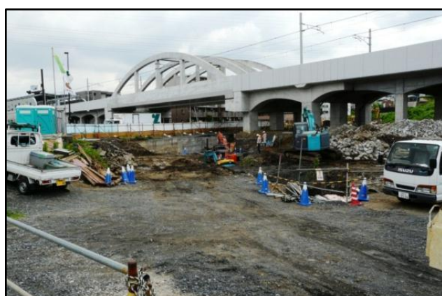
写真B 10街区工事箇所
