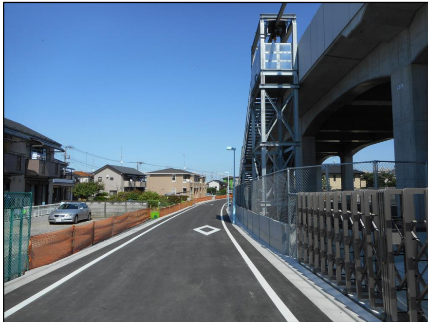
図5 北側側道写真
