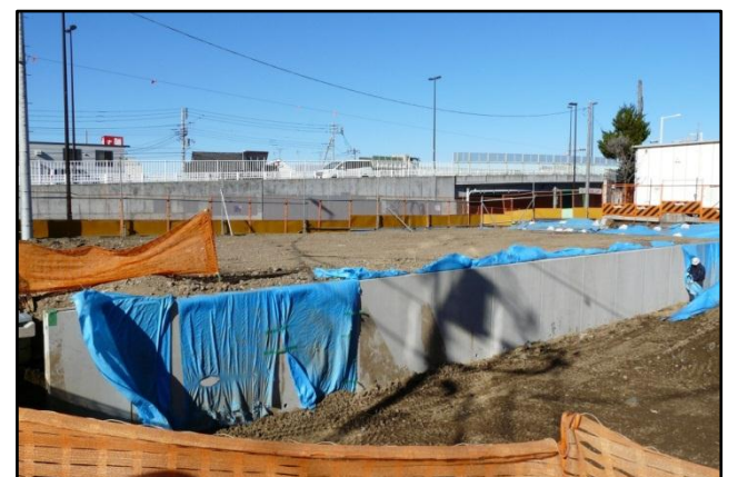
写真 C 13 街区工事箇所
