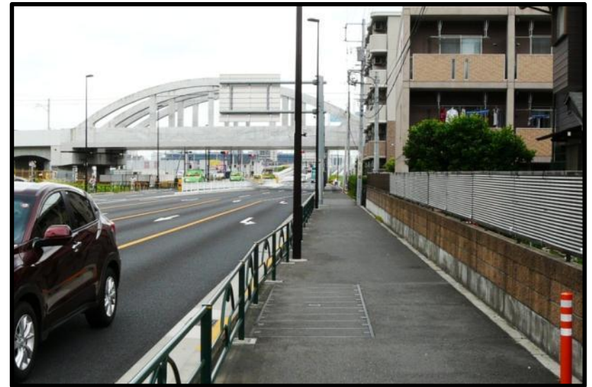
写真D 今年度工事予定の歩道
