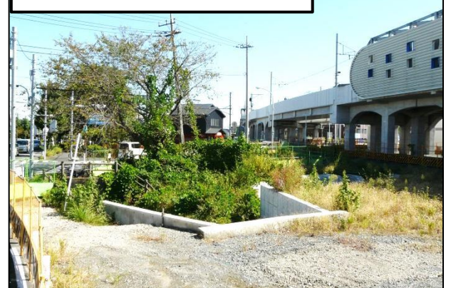
写真C 3号公園整備工事
