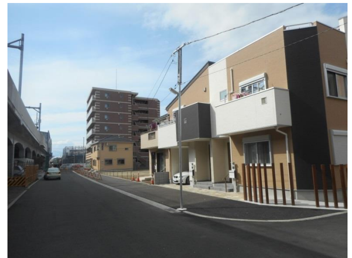
(写真②) 駅北口の整備状況
