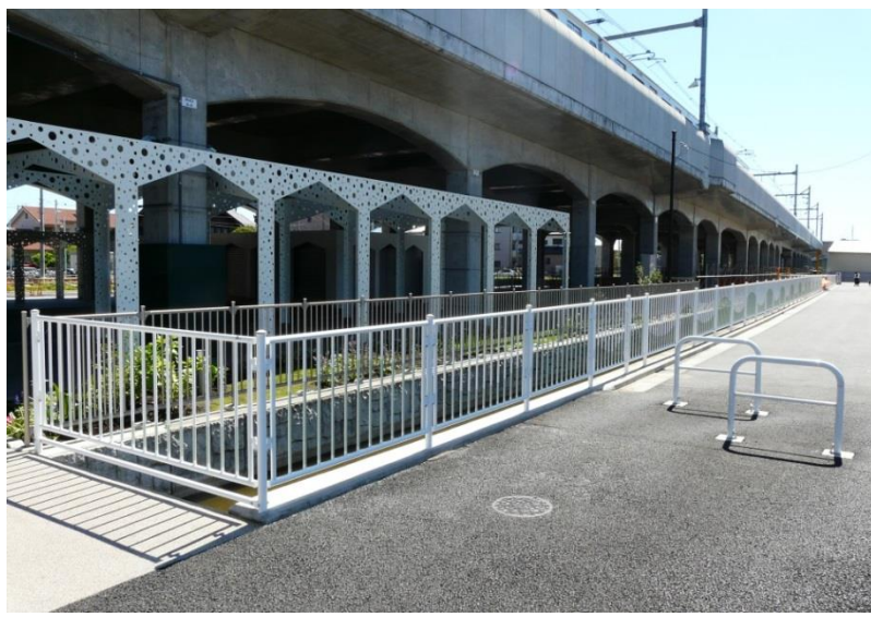
(写真④) 転落防止柵の整備状況
