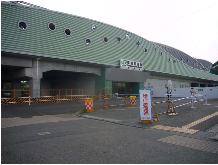
(写真①) 駅北口の整備状況
