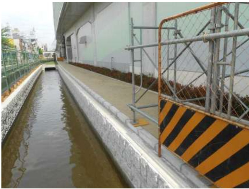
(写真①) 新たな新堀水路
