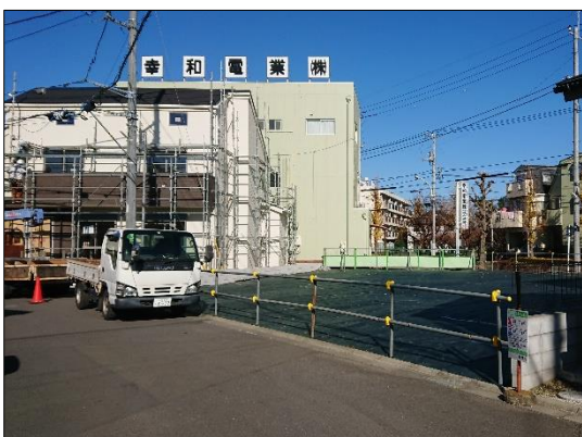
整地工事が完了
